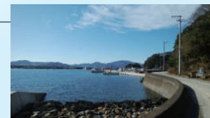
寺間港へ続く道
